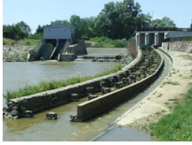
A legutóbb munkába állt negyedik új, a szentgotthárdi „csigás” erőmű. Ez a megoldás akkor jó, ha kicsi, 250 cm körüli a felvív és az alvíz szintkülönbsége. Jobbra a hallépcső, a mellette lévő csatorna a kajakcsúszda
